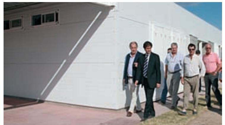
Bibiloni y Pittelli, intendente de Chivilcoy, recorrieron las instalaciones
